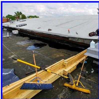
faltando. Trabajos de reducción de tapajuntas, el reemplazo de flashing y el trabajo de albañilería relacionado se ha completado en la Escuela Primaria Barley Sheaf. Pravco tuvo el beneficio del buen clima en los últimos días.
