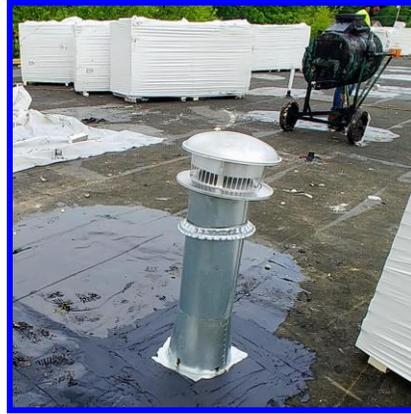
Se retiró la vieja chimenea de ladrillo en la parte superior de Barley Sheaf. Se instaló una nueva chimenea de metal de doble pared para servir el calentador de agua caliente. El trabajo se ha concentrado en Barley Sheaf durante algunas semanas, pero se ha trasladado
